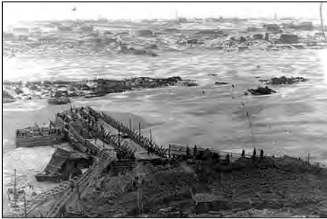
Початок будівництва Дніпрогесу
