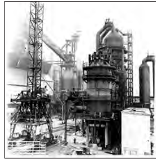
Будівництво домни на Криворіжсталі
